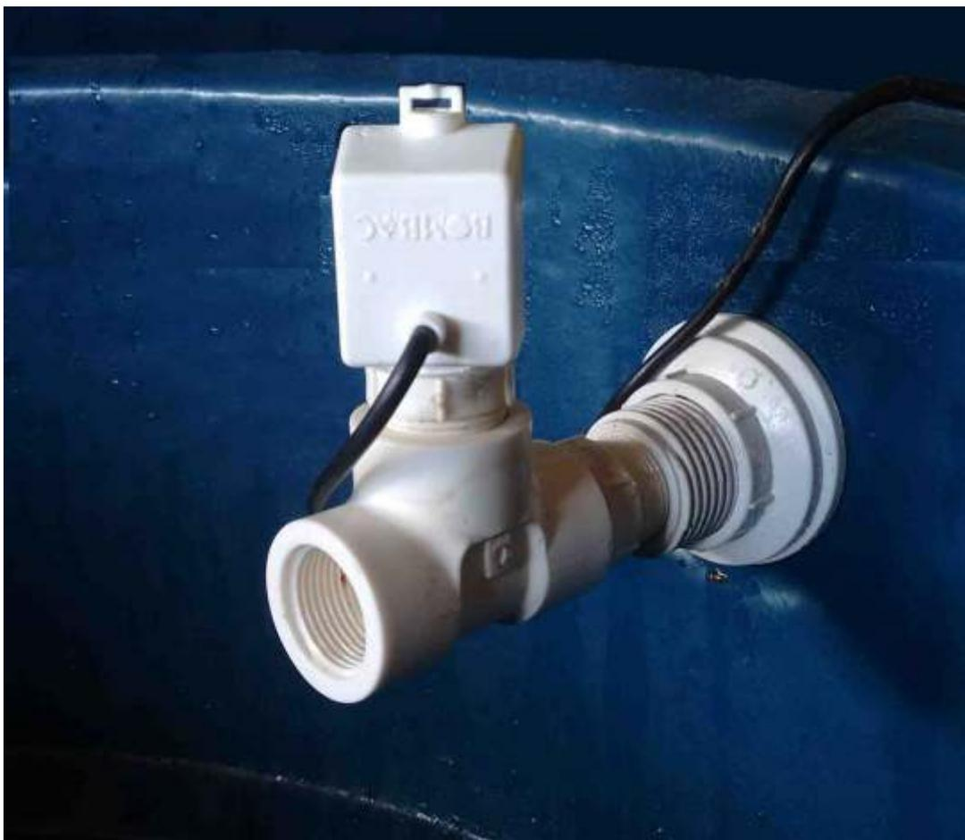
O Detector de agua é instalado na entrada de água da caixa d'agua ou reservatório superior através de um «Te», como mostra a figura. Se necessário ele pode ficar na horizontal para permitir o fechamento da tampa. Não deve ficar virado para baixo para evitar acumular água nos eletrodos.
